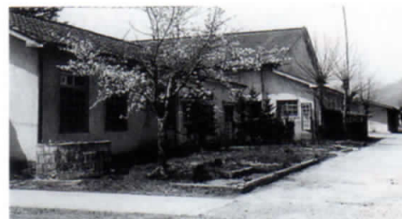
旧機械科校舎と実習室
