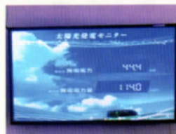
発電状況を生徒へ (モニター)
