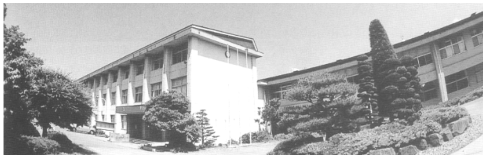
南校舎、この屋根に太陽光パネルが設置されています。
