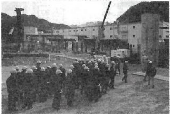
工事中の現場を見学する様子
