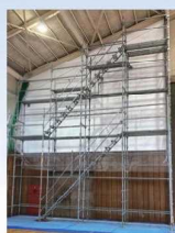
体育館塗装工事
