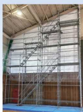
体育館塗装工事
