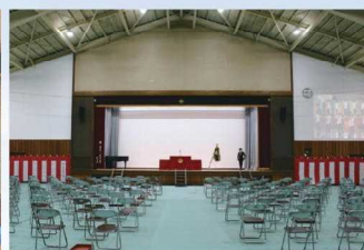
ステージ壁面塗装工事
