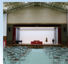
ステージ壁面塗装工事
