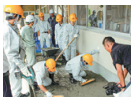
事務室前スロープ設置
